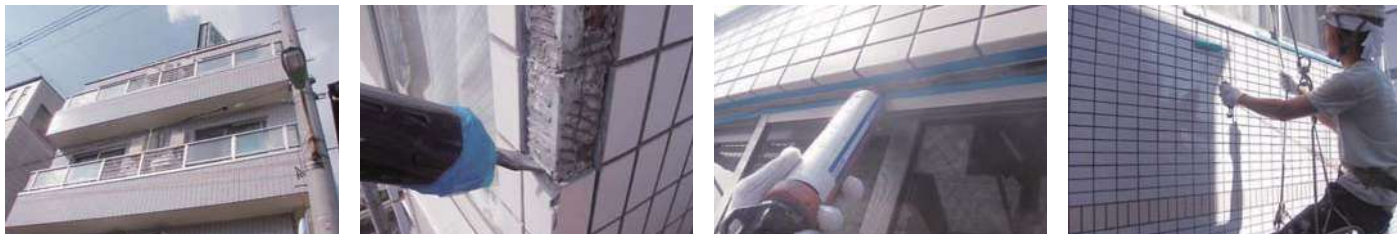
34 物件名 ▶ カーサビアンカ(練馬区旭町) 施工期日:平成22年10月/施工内容:外部改修
