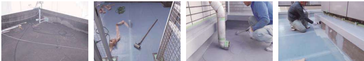
32 物件名 ▶ 秀和代官山レジデンス(渋谷区猿楽町) 施工期日:平成22年9月下旬~10月中旬/施工内容:屋根斜面壁塗装
