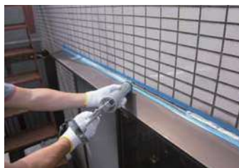
18 物件名▶ベルテックスビル(北区滝野川) 施工期日:平成22年7月/施工内容:シーリング
