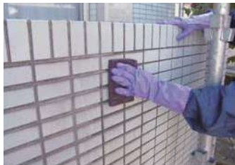
38 物件名 ▶ クレインズハウス(中野区弥生町) 施工期日:平成22年11月/施工内容:外壁タイル洗浄、クリアー塗装
