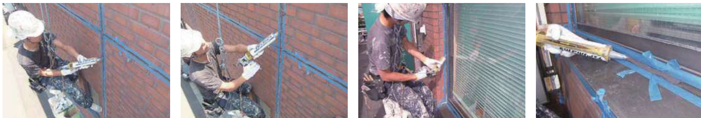
21 物件名 ▶ ハイッツサンライズ(世田谷区深沢) 施工期日:平成22年6月/施工内容:シーリング
