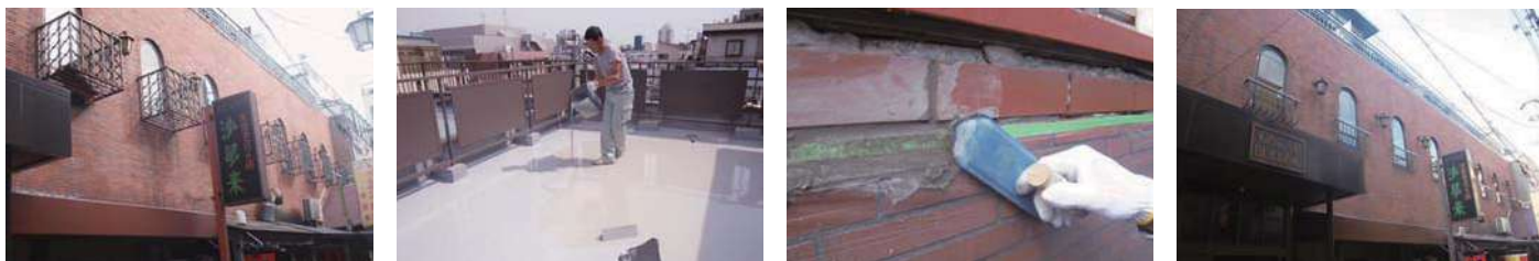
18 物件名 ▶ 郵船商事御成門ビル(港区芝公園) 施工期日:平成25年4月/施工内容:北面サッシ周りシーリング、防水工事
