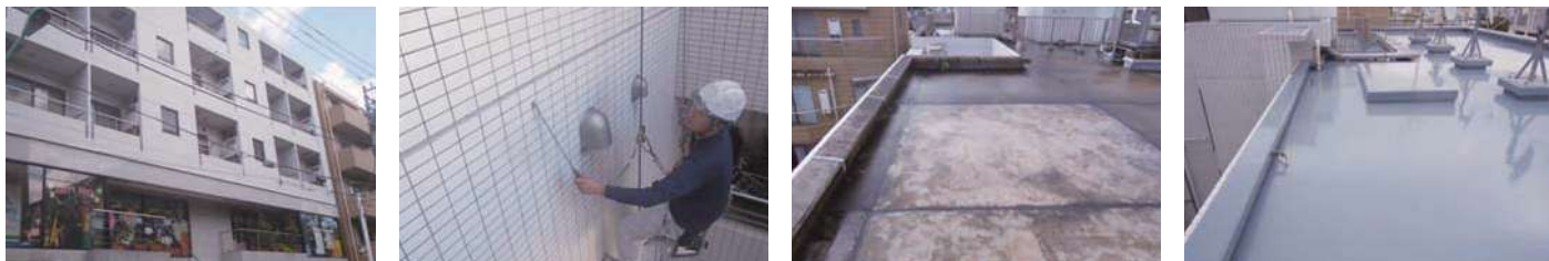
45 物件名 ▶ 栄新マンション(新宿区新宿) 施工期日:平成25年10月/施工内容:外部改修工事
