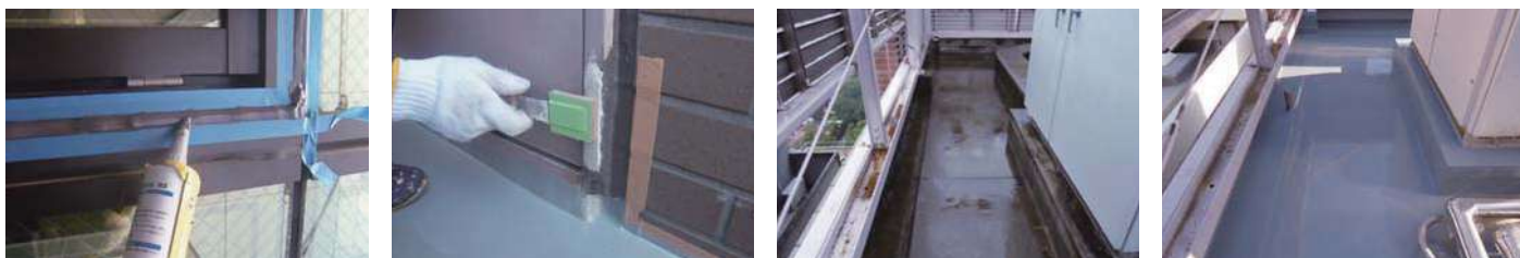
18 物件名 ▶ 郵船商事御成門ビル(港区芝公園) 施工期日:平成25年4月/施工内容:北面サッシ周りシーリング、防水工事
