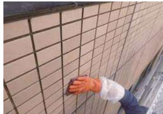
41 物件名 ▶ 吉田工商ビル(練馬区早宮) 施工期日:平成25年9月/施工内容:外壁シーリング、タイルクリーニング工事
