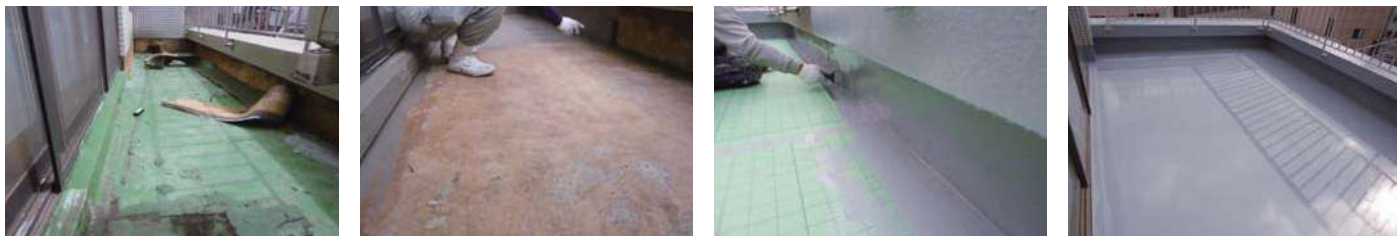
15 物件名 ▶ 王子ハイムやまわ(北区王子) 施工期日:平成25年4月/施工内容:外壁補修工事
