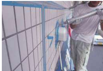
40 物件名 ▶ MIビル(新宿区北新宿) 施工期日:平成25年9月/施工内容:タイル面シーリング・セットバックタイル補修工事
