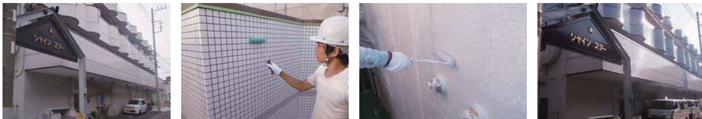
32 物件名▶ソーシャル広小路ビル(文京区湯島) 施工期日:平成25年7月~9月/施工内容:外部改修工事
