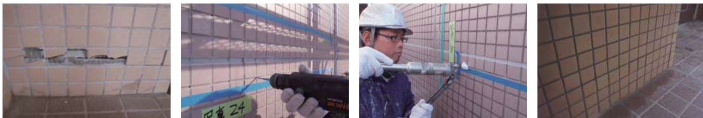
16 物件名 ▶ 城北信用金庫新堀(川口市峯) 施工期日:平成25年4月/施工内容:外壁塗装工事
