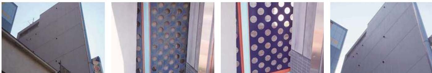
47 物件名 ▶ 城北信用金庫本店営業部(荒川区荒川) 施工期日:平成25年11月/施工内容:塔屋外壁改修工事
