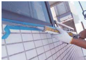
41 物件名 ▶ 吉田工商ビル(練馬区早宮) 施工期日:平成25年9月/施工内容:外壁シーリング、タイルクリーニング工事
