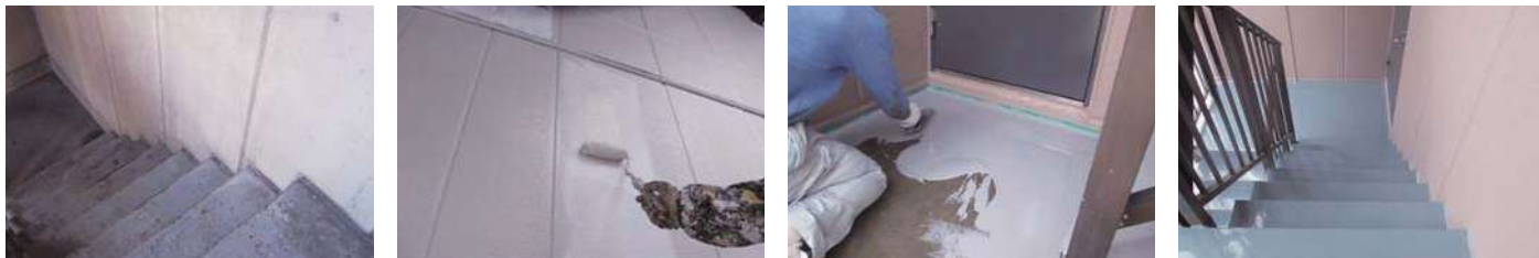
34 物件名▶サンライズ渋谷(渋谷区円山町) 施工期日:平成25年7月/施工内容:外壁塗装工事
