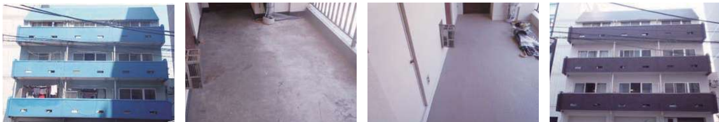
46 物件名 ▶ スプリングビル(江東区亀戸) 施工期日:平成25年10月/施工内容:東面外壁塗装工事
