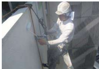
76 物件名▶ITCビル(千代田区神田須田町) 施工期日:平成27年9月／施工内容:右側面漏水補修工事
