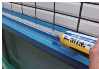
77 物件名▶Nビル(中央区東日本橋) 施工期日:平成27年10月／施工内容:10階バルコニー防水、漏水箇所周り調査、補修工事
