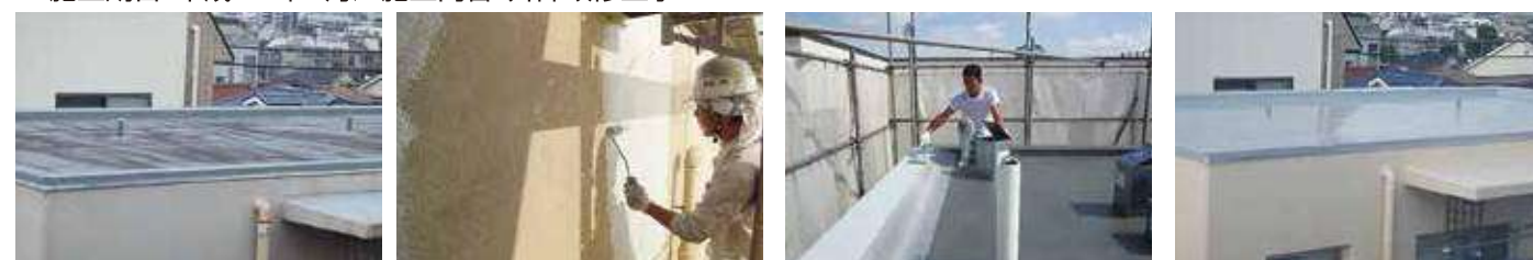
58 物件名▶中島整形外科(府中市白糸台) 施工期日:平成28年8月/施工内容:外部塗装工事
