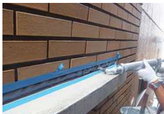
66 物件名▶アトリエコレクションビル(練馬区大泉学園町) 施工期日:平成28年10月／施工内容:廊下防水
