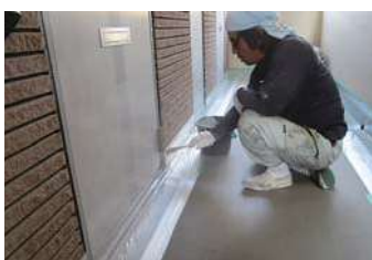
66 物件名▶アトリエコレクションビル(練馬区大泉学園町) 施工期日:平成28年10月／施工内容:廊下防水
