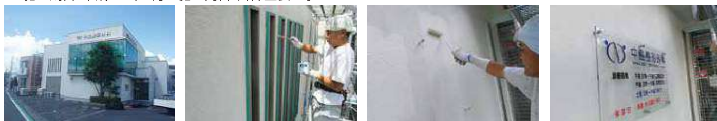
59 物件名▶サンテラス久我山(杉並区久我山) 施工期日:平成28年9月/施工内容:外部改修工事
