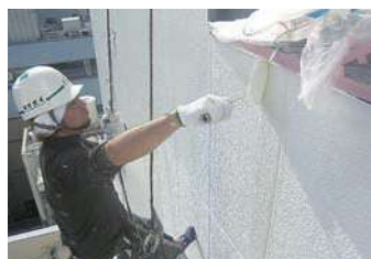
65 物件名▶竜星ハイツ(世田谷区深沢) 施工期日:平成28年9月／施工内容:タイル外壁シーリング工事
