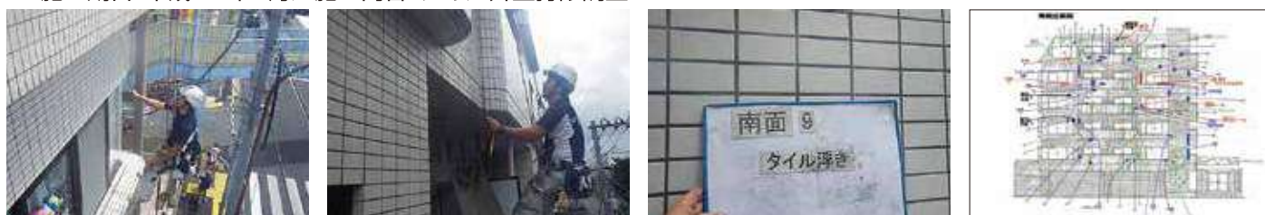
57 物件名▶卯月フラット(世田谷区大原) 施工期日:平成28年8月/施工内容:外部改修工事
