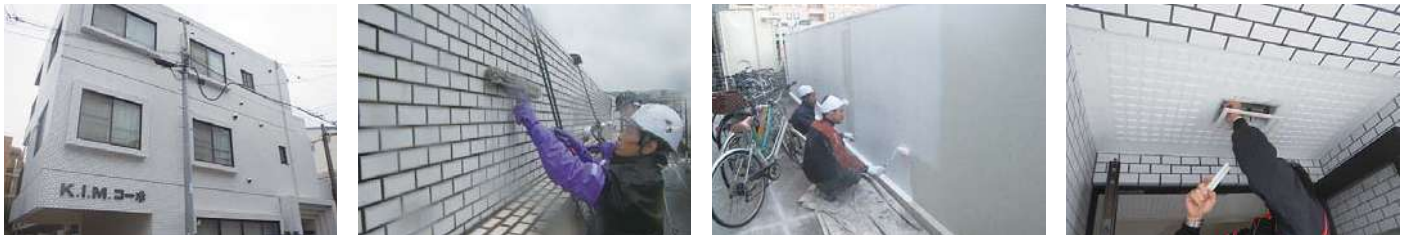
76 物件名▶ コンフォート関町(練馬区関町東) 施工期日:平成29年10月／施工内容:タイル外壁打診調査
