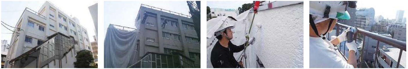
74 物件名▶ 風雲堂本館(千代田区神田小川町) 施工期日:平成29年9月／施工内容:タイル外壁打診調査
