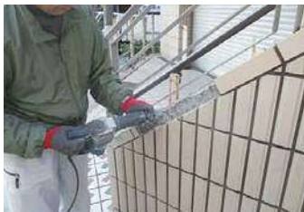
34 物件名▶メゾンド高木(世田谷区深沢) 施工期日:平成29年4月／施工内容:タイル壁打診調査、補修工事
