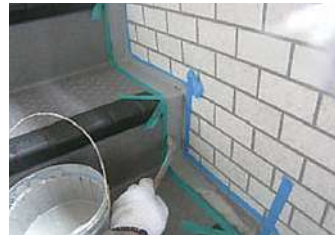
135 物件名▶クリスタルハイム(大田区大森南) 施工期日: 令和2年7月 / 施工内容: 開放廊下、階段内長尺シート貼り替え工事
