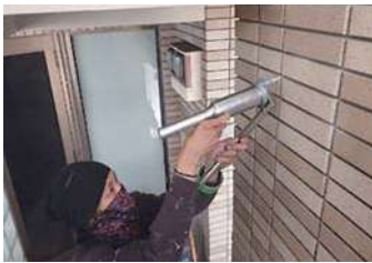
101 物件名 ▶ サンヒルズ東川口(川口市東川口) 施工期日: 令和2年5月 / 施工内容: 漏水補修工事
