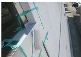
129 物件名 ▶ 東京女子医科大学中央病棟(機械室北面笠木爆裂)(新宿区河田町) 施工期日: 令和2年6月 / 施工内容: 中央病棟、機械室北面塔屋笠木爆裂補修工事
