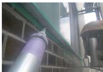
188 物件名 ▶ イチカワ・コーポレーションビル(さいたま市浦和区) 施工期日: 令和2年9月 / 施工内容: 正面壁タイル補修工事
