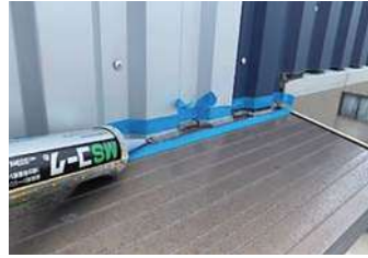
134 物件名▶グランサイト六笠No1(足立区千住元町) 施工期日: 令和2年7月 / 施工内容: 樋バンド付根金具交換
