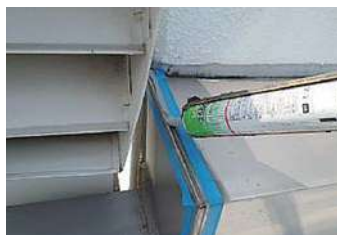
77 物件名▶ラメール代々木上原(渋谷区上原) 施工期日: 令和2年4月 / 施工内容: 401号室玄関上部漏水補修工事
