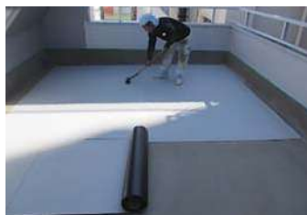
192 物件名 ▶ ホワイトシティⅡ(調布市西つつじヶ丘) 施工期日: 令和2年9月 / 施工内容: ウレタン塗膜防水工事
