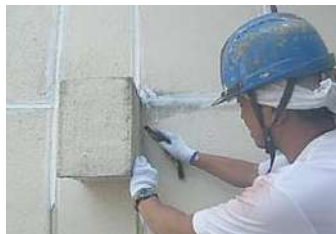
128 物件名 ▶ 東京女子医科大学西病棟(B2階)(新宿区河田町) 施工期日: 令和2年6月 / 施工内容: 西病棟B2階低層部屋上、カテ室側面漏水補修工事
