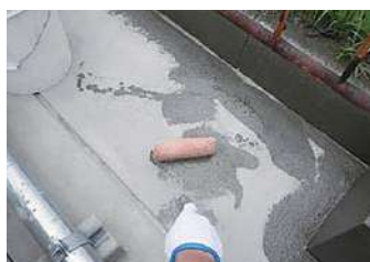
129 物件名 ▶ 東京女子医科大学中央病棟(機械室北面笠木爆裂)(新宿区河田町) 施工期日: 令和2年6月 / 施工内容: 中央病棟、機械室北面塔屋笠木爆裂補修工事
