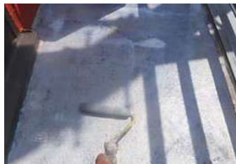
164 物件名 ▶ ミヤコヤビル(港区南青山) 施工期日: 令和2年8月 / 施工内容: 4階・5階非常口漏水補修工事
