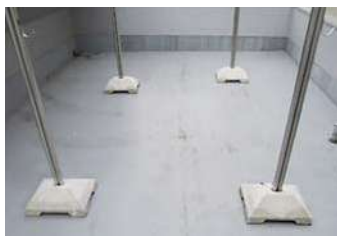
192 物件名 ▶ ホワイトシティⅡ(調布市西つつじヶ丘) 施工期日: 令和2年9月 / 施工内容: ウレタン塗膜防水工事
