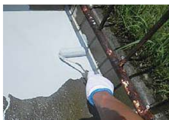
129 物件名 ▶ 東京女子医科大学中央病棟(機械室北面笠木爆裂)(新宿区河田町) 施工期日: 令和2年6月 / 施工内容: 中央病棟、機械室北面塔屋笠木爆裂補修工事
