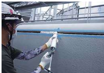
93 物件名▶仙田ビル(世田谷区北沢) 施工期日:令和3年7月/施工内容:5階窓廻りシーリング工事
