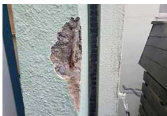
96 物件名▶東常盤松マンション(渋谷区東) 施工期日:令和3年7月/施工内容:外壁ひび割れ、爆裂補修工事
