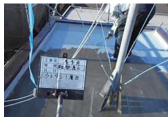
132 物件名▶東京女子医科大学(新宿区河田町) 施工期日:令和3年10月/施工内容:西病棟B4階屋上、カテ室上部漏水補修工事
