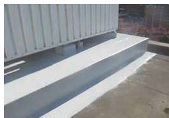
132 物件名▶東京女子医科大学(新宿区河田町) 施工期日:令和3年10月/施工内容:西病棟B4階屋上、カテ室上部漏水補修工事
