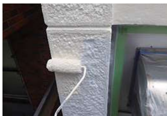
96 物件名▶東常盤松マンション(渋谷区東) 施工期日:令和3年7月/施工内容:外壁ひび割れ、爆裂補修工事
