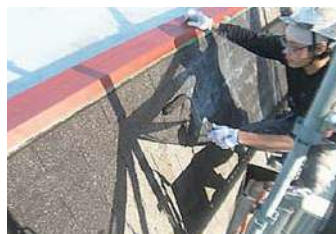
132 物件名▶東京女子医科大学(新宿区河田町) 施工期日:令和3年10月/施工内容:西病棟B4階屋上、カテ室上部漏水補修工事
