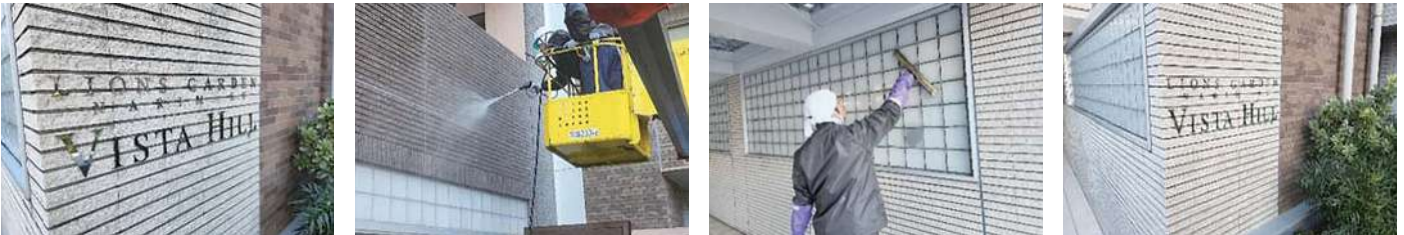
16 物件名 ▶ 井上ビル (荒川区南千住) 施工期日: 令和5年2月 / 施工内容: 屋上防水工事
