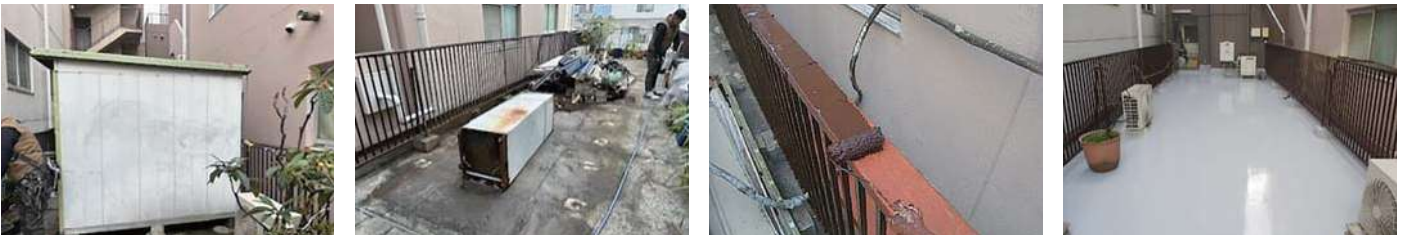
17 物件名 ▶ 吉田ビル (荒川区南千住) 施工期日: 令和5年2月 / 施工内容: 屋上防水工事
