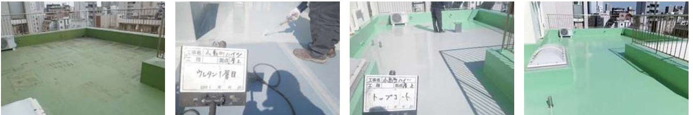
22 物件名 ▶ 松江マンション(埼玉県草加市松江) 施工期日: 令和5年2月 / 施工内容: 301号室窓シーリング工事
