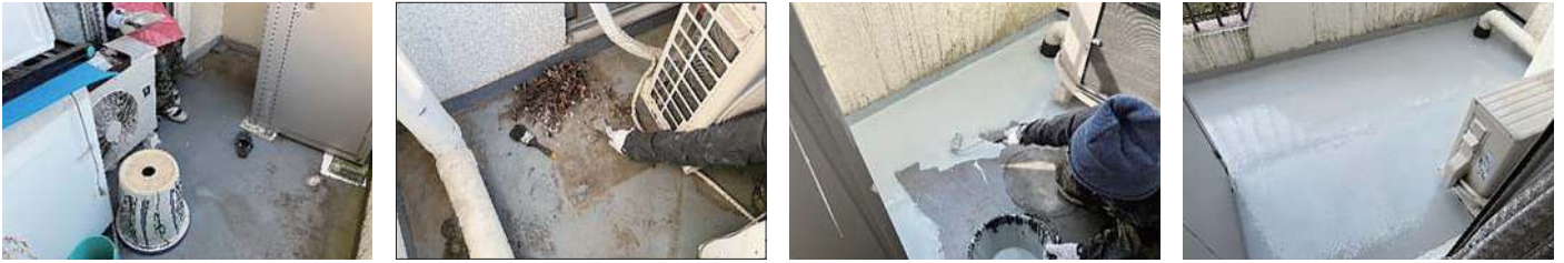
20 物件名 ▶ 市川製本所ビル(新宿区榎木町) 施工期日: 令和5年2月 / 施工内容: 6階バルコニー防水工事
