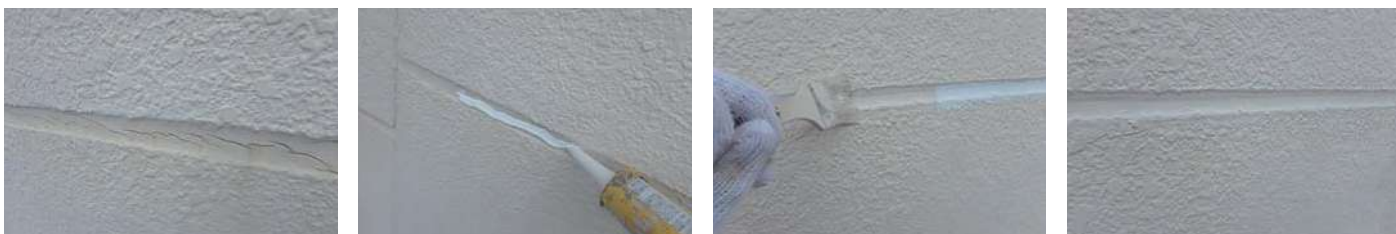
107 物件名 ▶ リプレースメント広尾(国分寺市東元町) 施工期日: 令和5年9月 / 施工内容: 正面シーリング工事
