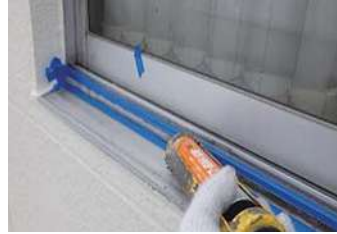
39 物件名 ▶ 田中金華堂(台東区台東) 施工期日: 令和5年3月 / 施工内容: シール撤去工事
