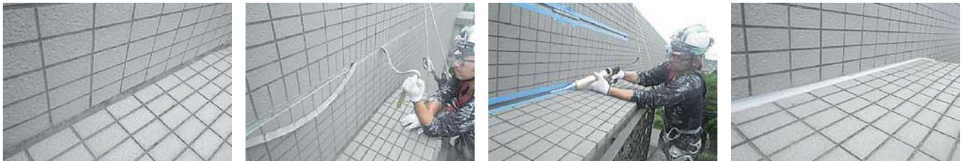
86 物件名 ▶ 吾妻ビル(台東区西浅草) 施工期日: 令和5年7月 / 施工内容: 正面2階窓下漏水補修工事
