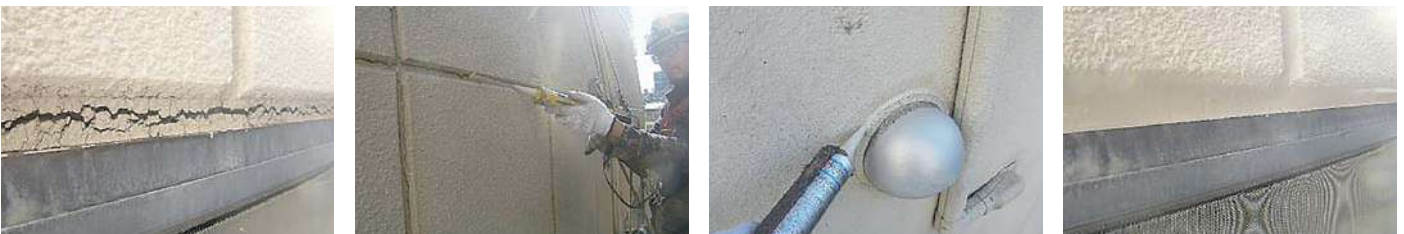
18 物件名 ▶ 吉田ビル (荒川区南千住) 施工期日: 令和5年2月 / 施工内容: 301号室窓周り漏水補修工事
