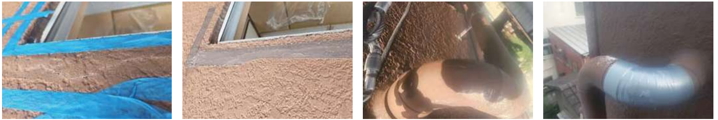
69 物件名 ▶ サンクレスト(江戸川区春江町) 施工期日: 令和5年6月 / 施工内容: 南西側窓周り補修工事
