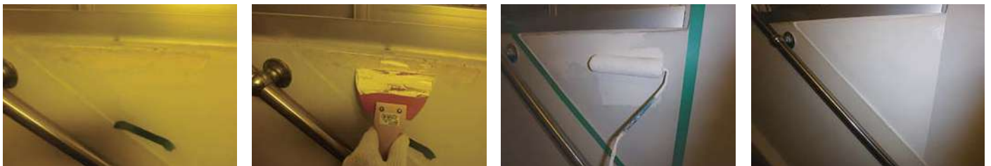
71 物件名 ▶ アークビル新中野(中野区中央) 施工期日: 令和5年6月 / 施工内容: 2階廊下、階段床長尺シート貼り工事
