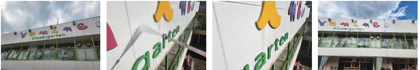
137 物件名 ▶ スカイハイツ富澤(足立区谷中) 施工期日: 令和5年11月 / 施工内容: ベランダ避難ハッチ廻りシーリング工事
