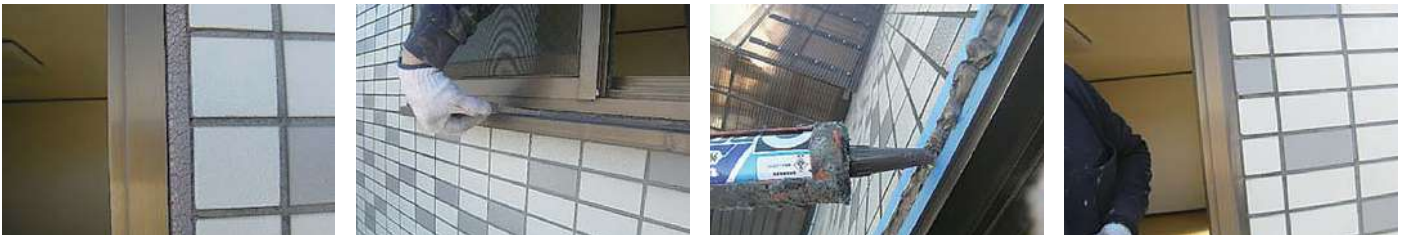
23 物件名 ▶ 水口邸(世田谷区等々力) 施工期日: 令和5年2月 / 施工内容: 外部塗装工事
