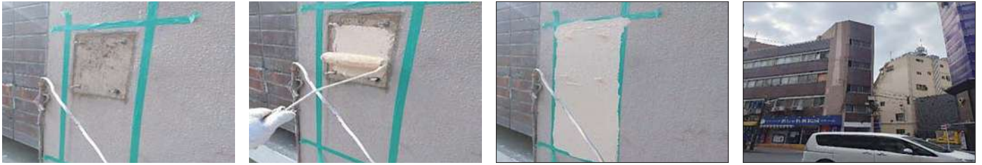
26 物件名▶長井ビル(港区西麻布) 施工期日:令和5年2月/施工内容:庇軒天面補修工事・手摺塗装工事
