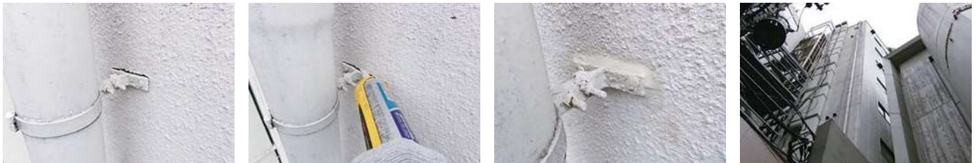
154 物件名 ▶ 丸加ビル(埼玉県坂戸市) 施工期日: 令和5年12月 / 施工内容: シーリング工事
