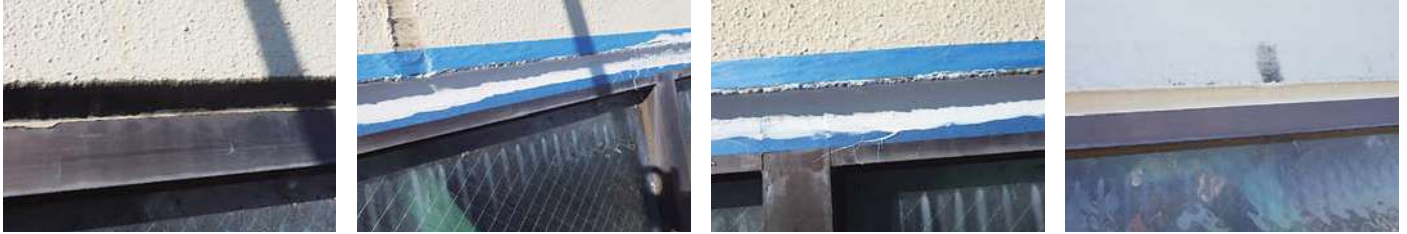
135 物件名 ▶ 無三四堂ビル(新宿区四谷) 施工期日: 令和5年10月 / 施工内容: 外壁補修工事
