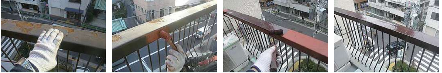
27 物件名▶東京女子医科大学(新宿区河田町) 施工期日:令和5年2月/施工内容:東病棟液体窒素タンク架台防水工事
