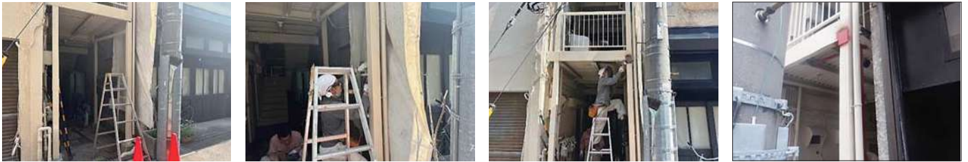
59 物件名 ▶ テラスTAMURA(豊島区上池袋) 施工期日: 令和5年5月 / 施工内容: 101号室内装工事
