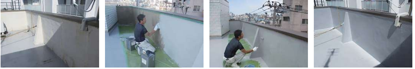
50 物件名 ▶ 櫻井様邸(江戸川区西小岩) 施工期日: 令和5年4月 / 施工内容: 正面タイル洗浄工事
