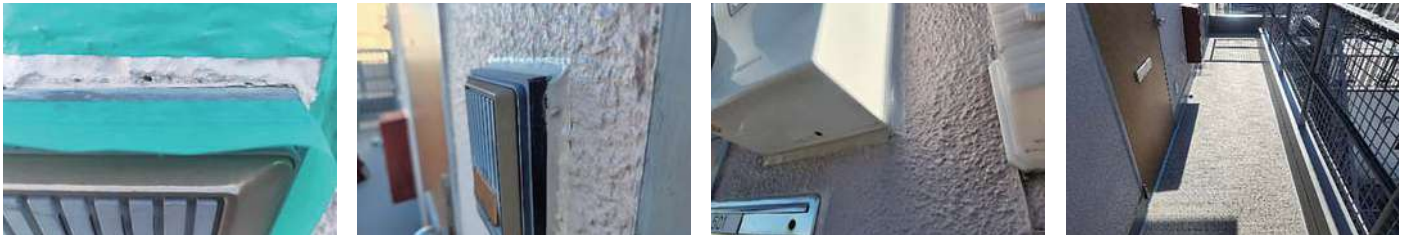
160 物件名 ▶ 三鷹オリエント丹野(武蔵野市中町) 施工期日: 令和5年12月 / 施工内容: 4階北面外壁補修工事
