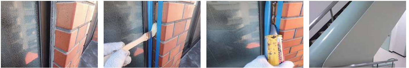
161 物件名 ▶ ニューフジビル(品川区上大崎) 施工期日: 令和5年12月 / 施工内容: 階段・廊下内工事
