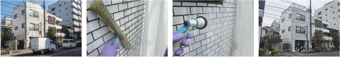
51 物件名 ▶ ヴィラ・デ・ソレイユ(北区上十条) 施工期日: 令和5年5月 / 施工内容: タイル洗浄・シーリング工事
