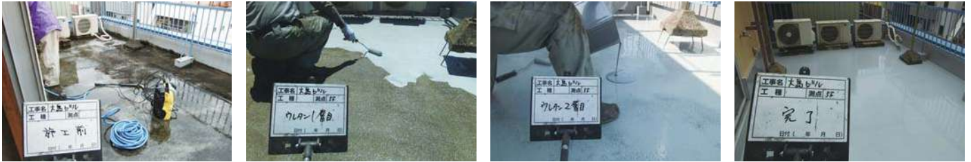
58 物件名 ▶ 尾崎様所有マンション(台東区鳥越) 施工期日: 令和5年5月 / 施工内容: 鉄骨階段支柱補修工事
