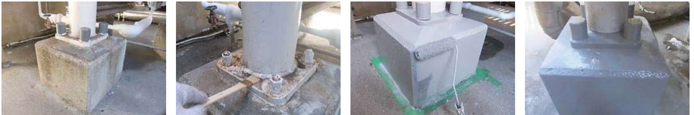
28 物件名▶東京女子医科大学(新宿区河田町) 施工期日:令和5年2月/施工内容:東病棟液体窒素タンク架台左官補修工事
