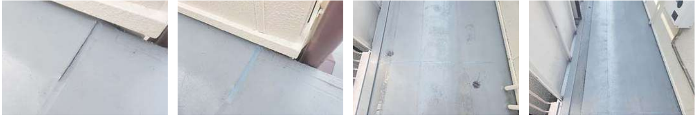
153 物件名 ▶ モリウチビル(千葉県船橋市) 施工期日: 令和5年12月 / 施工内容: 東南角面外壁調査補修工事
