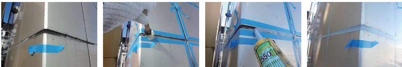
142 物件名 ▶ 東京女子医科大学(新宿区河田町) 施工期日: 令和5年11月 / 施工内容: 西病棟中庭部分防水工事
