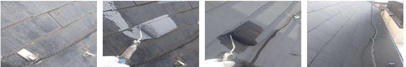
52 物件名 ▶ ビクトリアマンション(台東区千束) 施工期日: 令和5年5月 / 施工内容: 外部改修工事
