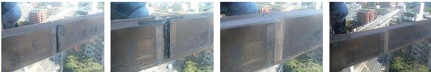
106 物件名 ▶ 富澤マンション(足立区谷中) 施工期日: 令和5年9月 / 施工内容: 両妻面外壁ひび割れ補修工事
