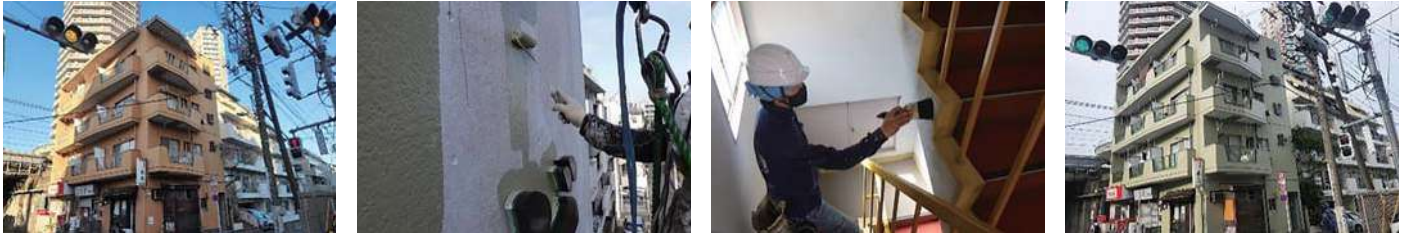
56 物件名 ▶ 青戸ダイヤモンドパレス(葛飾区青戸) 施工期日: 令和5年5月 / 施工内容: 外部階段塗装工事
