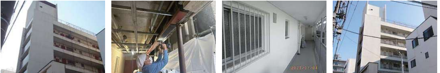
53 物件名 ▶ ライムハイツ(江戸川区東葛西) 施工期日: 令和5年5月 / 施工内容: 外部改修工事
