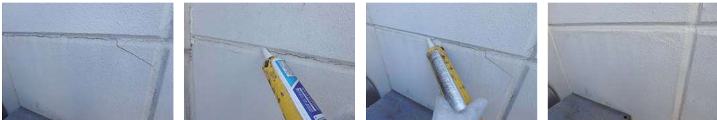
141 物件名 ▶ 弘城東口ビル(大田区蒲田) 施工期日: 令和5年11月 / 施工内容: 7階補修工事
