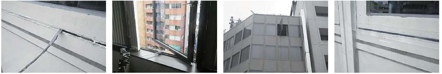
152 物件名 ▶ カサヴェール碑文谷(目黒区碑文谷) 施工期日: 令和5年11月 / 施工内容: 2階廊下床補修工事
