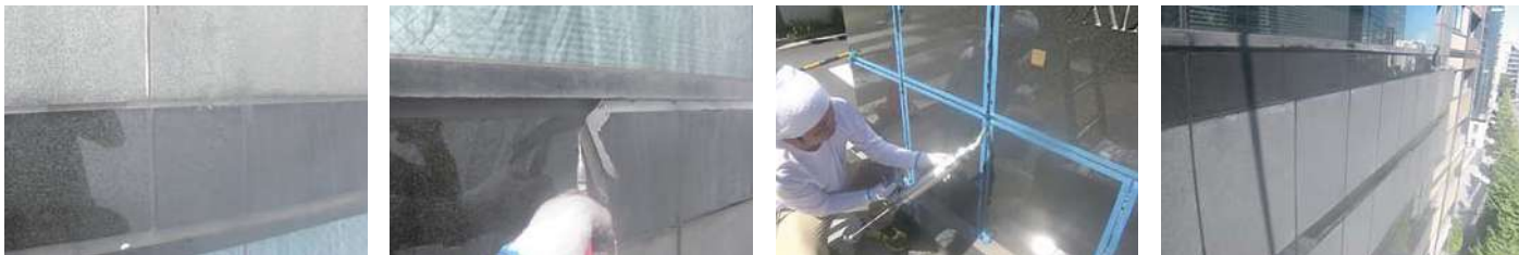
105 物件名 ▶ ライティングビル(多摩市落合) 施工期日: 令和5年9月 / 施工内容: 8階漏水補修工事
