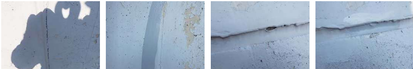
140 物件名 ▶ 弘城3号ビル(大田区蒲田) 施工期日: 令和5年11月 / 施工内容: 7階8階補修工事
