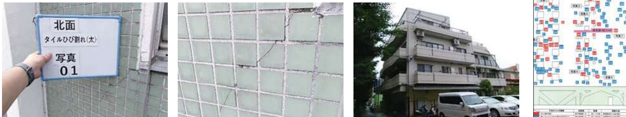
88 物件名 ▶ 最上邸(江東区牡丹) 施工期日: 令和5年7月 / 施工内容: 屋斜壁部窓廻りシーリング打ち換え工事
