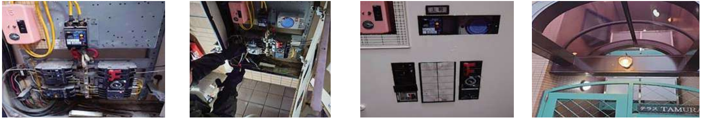
14 物件名 ▶ ホワイトウイング (品川区小山) 施工期日: 令和5年2月 / 施工内容: 501号バルコニー防水他工事
