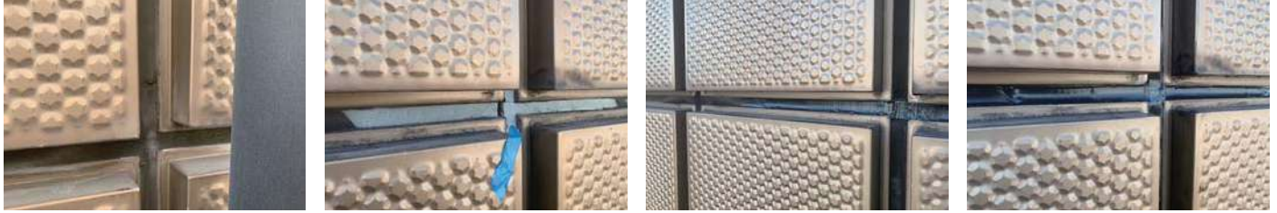
165 物件名 ▶ マーベラス大協ビル(葛飾区亀有) 施工期日: 令和5年12月 / 施工内容: 外部改修工事
