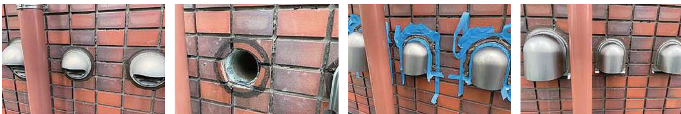
108 物件名 ▶ 鹿鳴館Ⅱ(豊島区长崎) 施工期日: 令和5年9月 / 施工内容: 302号ベントキャップ交換工事
