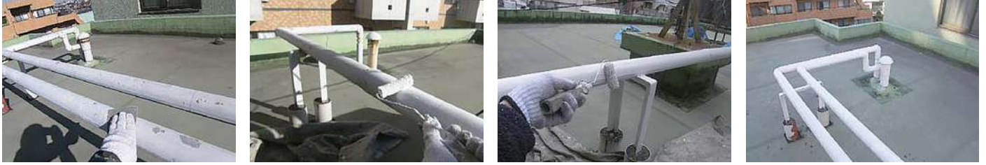
158 物件名 ▶ ベストライフ西東京松の木(西東京市下保谷) 施工期日: 令和5年12月 / 施工内容: 防水層保護トップ塗装工事
