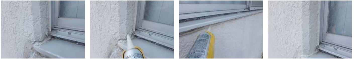
68 物件名 ▶ 工藤ビル(墨田区横川) 施工期日: 令和5年6月 / 施工内容: 東面漏水補修工事
