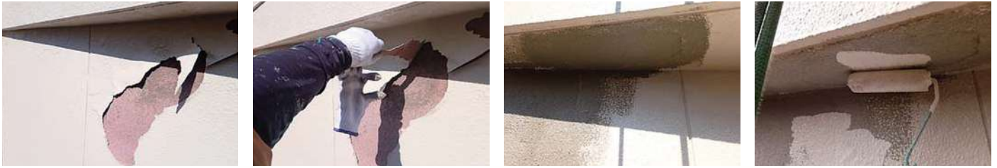
134 物件名 ▶ ウエストヒルズ(練馬区西大泉) 施工期日: 令和5年10月 / 施工内容: 3階サッシ廻り漏水補修工事
