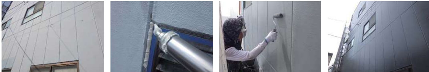
82 物件名▶国書刊行会国書日本語学校(板橋区志村) 施工期日: 令和7年8月 / 施工内容: 3階屋根塗装工事
