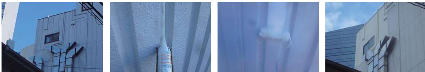
129 物件名 ▶ サンラザール(豊島区西池袋) 施工期日: 令和7年12月 / 施工内容: 外部改修工事
