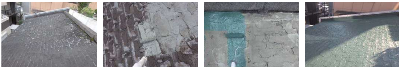
83 物件名▶仙田ビル(世田谷区北沢) 施工期日: 令和7年8月 / 施工内容: 正面6階部漏水補修工事
