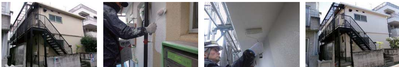
130 物件名 ▶ 銀星ビル(台東区根岸) 施工期日: 令和7年12月 / 施工内容: クラック補修工事
