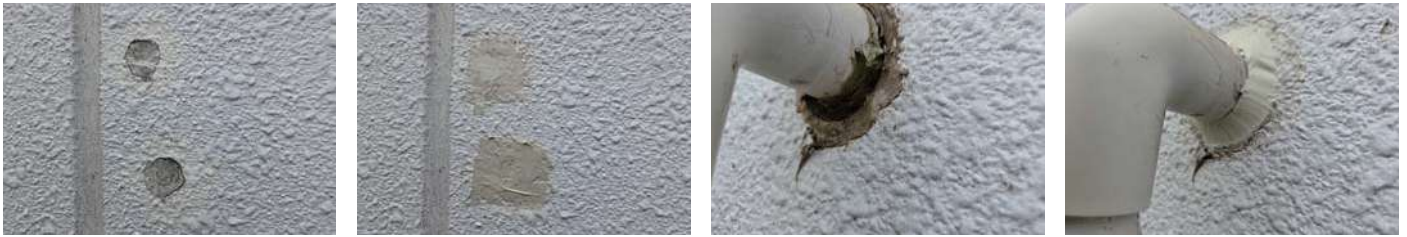
51 物件名▶ピアリッジ恵比寿(渋谷区恵比寿) 施工期日: 令和7年6月 / 施工内容: 外部改修工事
