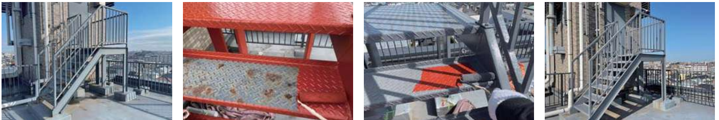
17 物件名▶セザール第三青梅(青梅市天ヶ瀬町) 施工期日:令和7年3月/施工内容:階段(エントランス側)手摺取り付け工事
