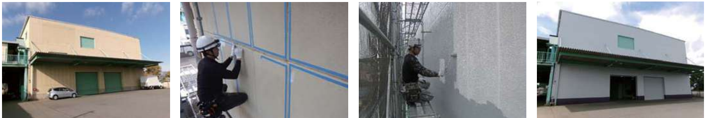
40 物件名▶エビス花園(渋谷区恵比寿西) 施工期日: 令和7年5月 / 施工内容: 外壁塗装工事
