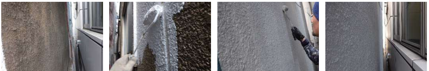
41 物件名▶グリーンヒルズ(練馬区大泉町) 施工期日: 令和7年5月 / 施工内容: 東妻面シーリング打ち替え工事
