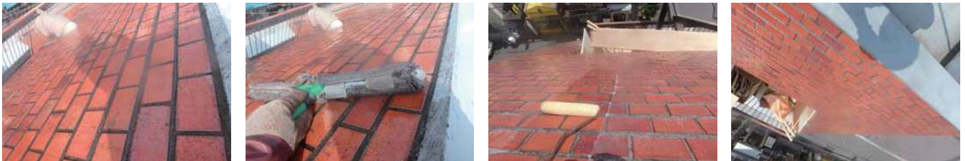
70 物件名 ▶ ホワイトビル(渋谷区神宮前) 施工期日: 令和7年7月 / 施工内容: 屋上防水工事
