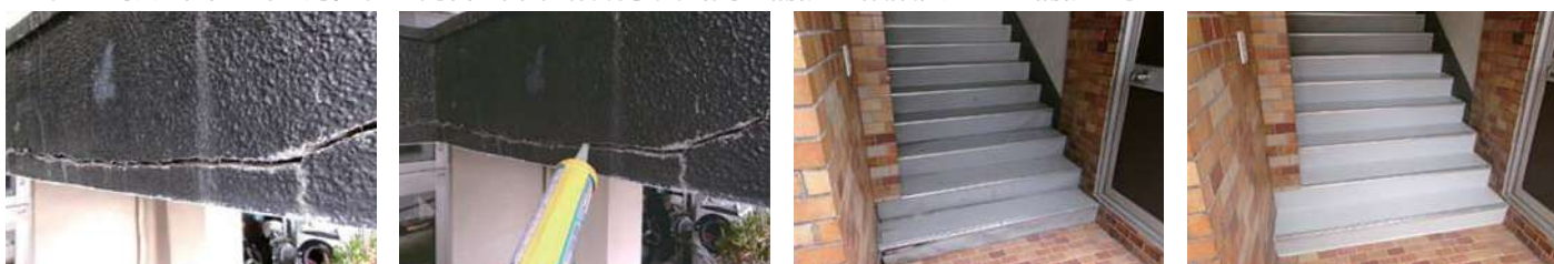
96 物件名 ▶ 南青山サンハイム(港区南青山) 施工期日: 令和7年9月 / 施工内容: EV機械室内壁防水工事
