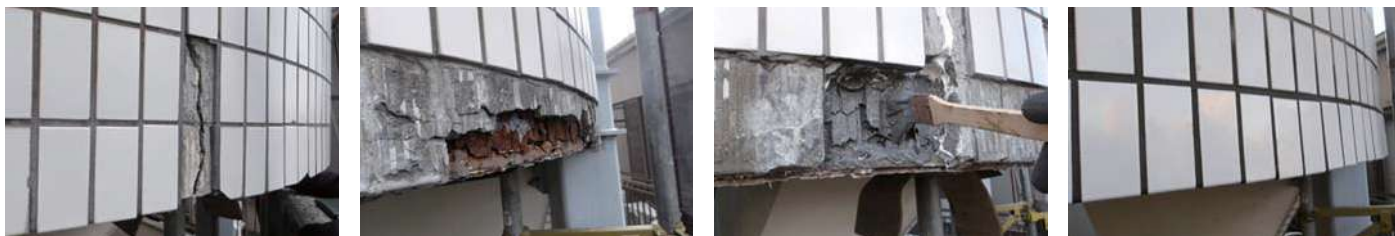
132 物件名 ▶ 東京ニットファッションアカデミー(荒川区西日暮里) 施工期日: 令和7年12月 / 施工内容: 階段タイル補修工事
