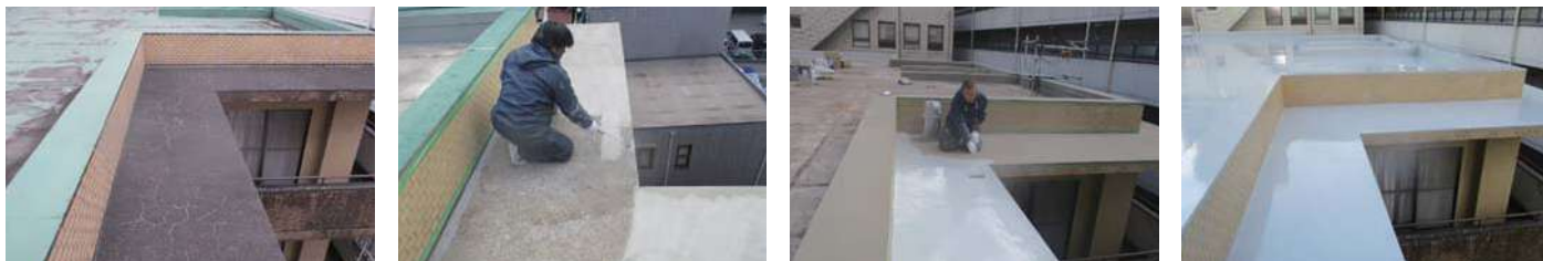
128 物件名 ▶ 米久ビル(港区六本木) 施工期日: 令和7年12月 / 施工内容: 6階部分塗装工事
