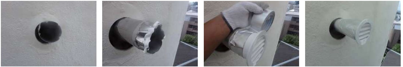
74 物件名▶第5アサヒハイツ(大田区東嶺) 施工期日: 令和7年7月 / 施工内容: 窓手摺塗装工事
