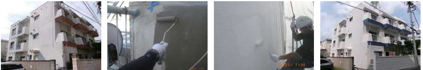
76 物件名▶TKグレイスビル(葛飾区新小岩) 施工期日: 令和7年8月 / 施工内容: 屋上防水、北東面外壁塗装工事
