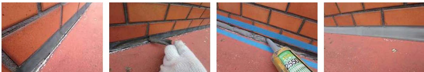
35 物件名 ▶ コーポみずがき(板橋区蓮根) 施工期日: 令和7年4月 / 施工内容: 外部改修工事
