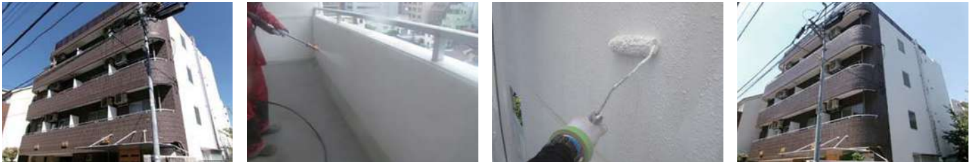
52 物件名▶フェリーハウス(板橋区舟渡) 施工期日: 令和7年6月 / 施工内容: 外部改修工事
