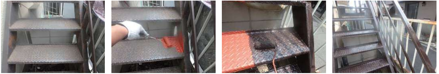
50 物件名▶バイセンタチカワ(立川市柏町) 施工期日: 令和7年6月 / 施工内容: 東面漏水補修工事
