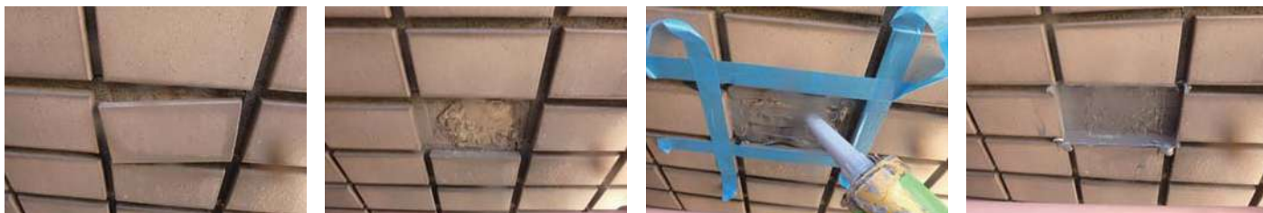
117 物件名 ▶ ベルシャトル武藤(蕨市中央) 施工期日: 令和7年11月 / 施工内容: 漏水補修工事
