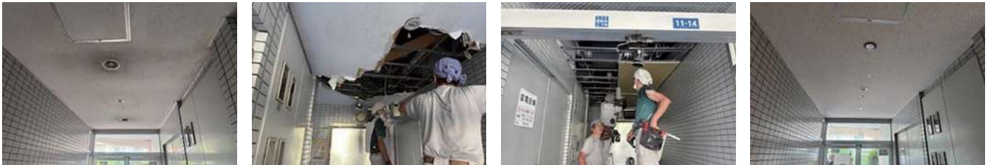
69 物件名 ▶ サンライズ新宿(新宿区百人町) 施工期日: 令和7年7月 / 施工内容: 屋上・斜壁タイル防水工事
