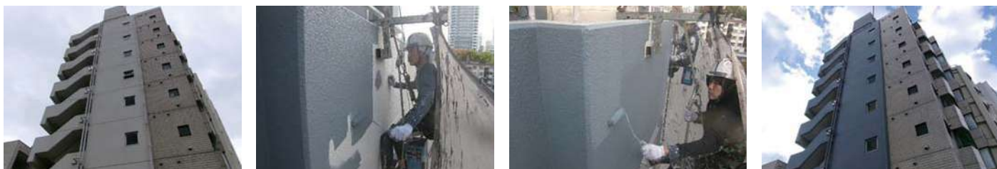
93 物件名 ▶ ロータリースリー(中央区日本橋人形町) 施工期日: 令和7年9月 / 施工内容: 外部改修工事
