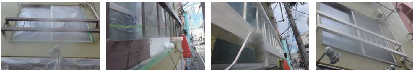
92 物件名 ▶ フリーデンカナメ(豊島区池袋) 施工期日: 令和7年9月 / 施工内容: 外部改修工事
