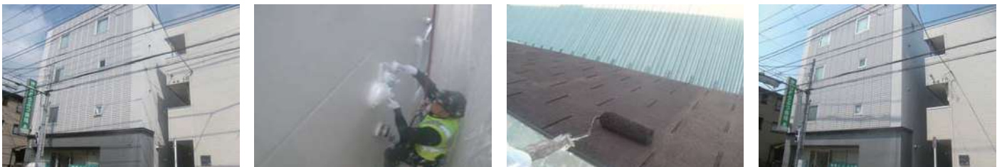
77 物件名▶TY2ビル(豊島区池袋) 施工期日: 令和7年8月 / 施工内容: 外部改修工事
