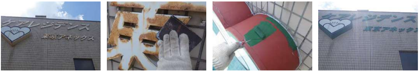
68 物件名 ▶ KMハウス(大田区西糀谷) 施工期日: 令和7年7月 / 施工内容: 部分改修工事
