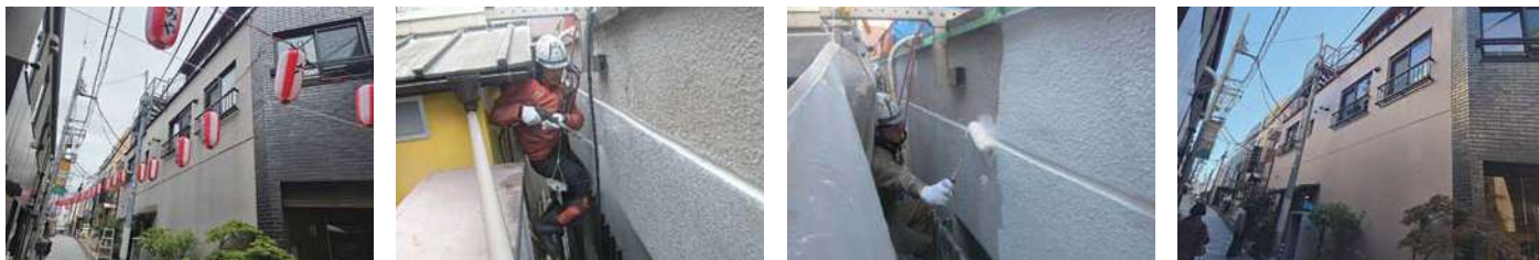
116 物件名 ▶ アイビーホームズ(豊島区駒込) 施工期日: 令和7年11月 / 施工内容: 6階タイル不具合部応急修理
