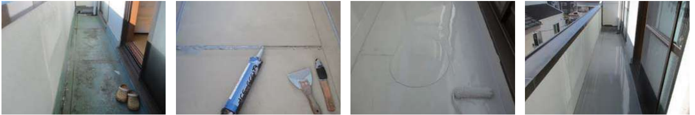
112 物件名 ▶ ホテルマーレ(品川区西五反田) 施工期日: 令和7年11月 / 施工内容: 屋上防水工事
