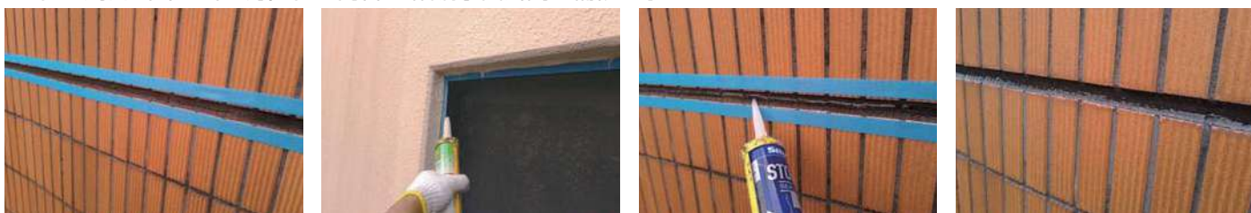
95 物件名 ▶ 長井ビル(港区西麻布) 施工期日: 令和7年9月 / 施工内容: 東面2階漏水箇所調査補修、1階階段シート補修工事
